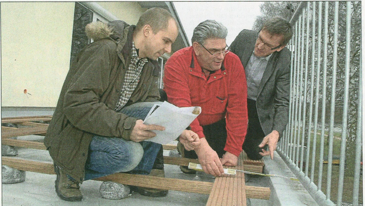
Endspurt auf der Terrasse: Architekt Lutz Leininger (KDL-Architekten, von links), Schlossermeister Bernd Himmel und Schulleiter Hans Jürgen Ziegler besprechen, wo die Metallabdeckung an der Brüstung montiert werden soll.
